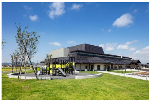
出典：新潟県五泉市 HP ラポルテ五泉 緑の広場
