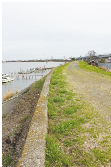
日光川堤防 雑木伐採後
