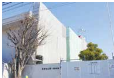
大規模改修工事中の第一保育所
