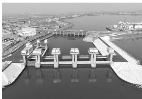
日光川水閘門
