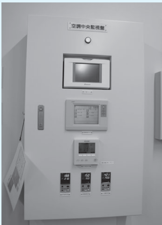
事務室にある制御盤
